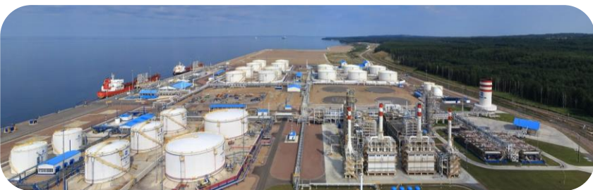
Новатэк - Усть - Луга, комплекс по перевалке и фракционированию стабильного газового конденсата и продуктов его переработки
