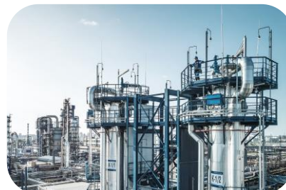
Московский НПЗ (АО «Газпромнефть-МНПЗ»)
