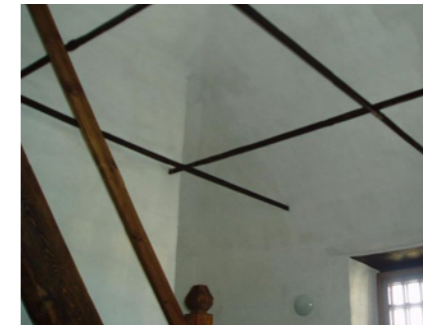
Арматура в акустической комнате Невьянской башни
